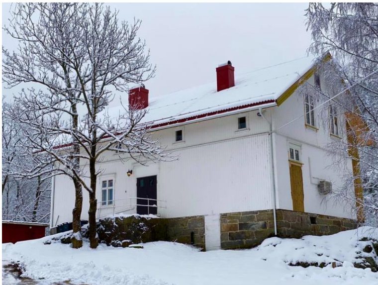
Heldal grendehus nærmer seg ferdig oppusset vinteren 20/21
