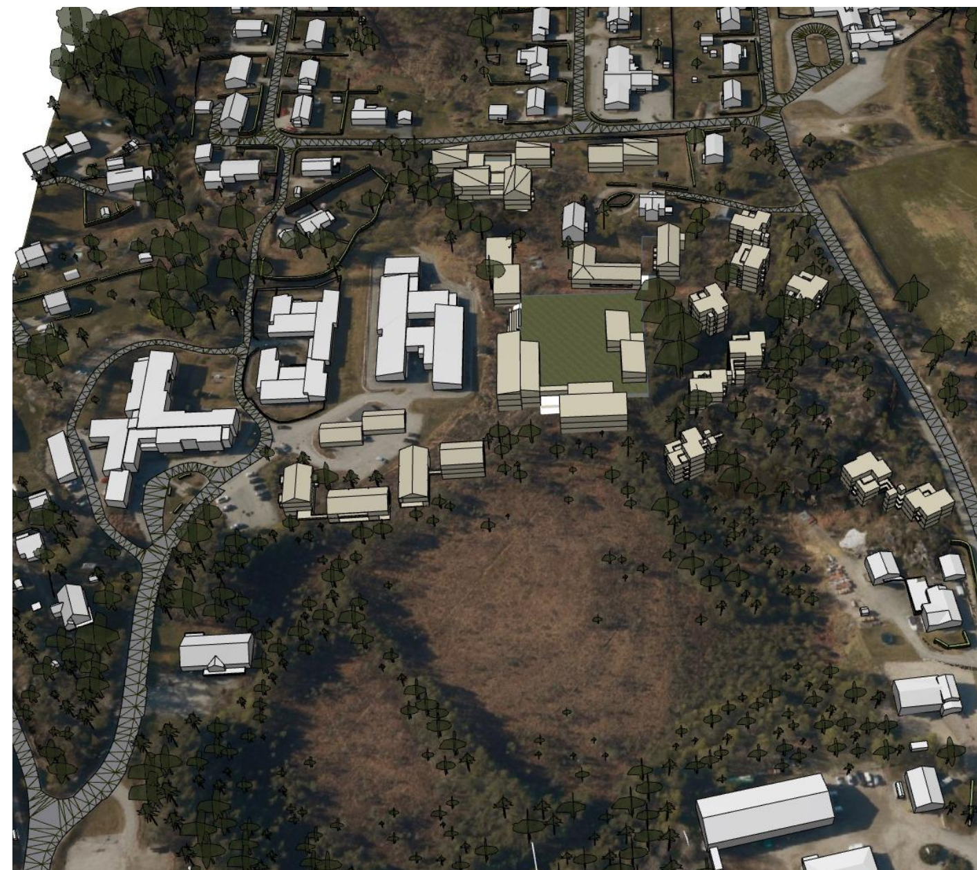
3d oversiktsbilde fra nord
