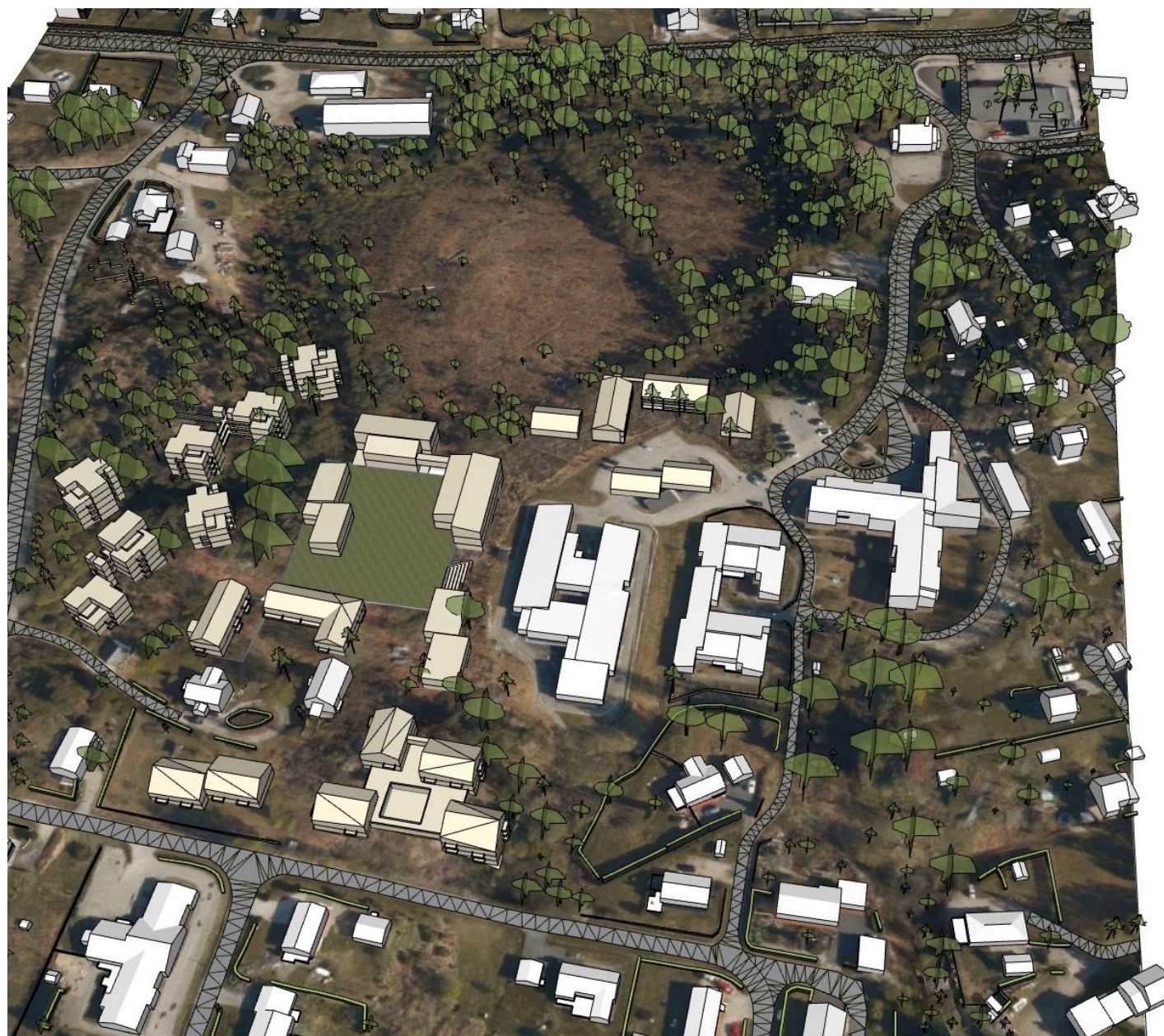
3d oversiktsbilde fra sør øst
